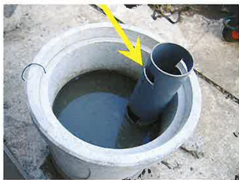
水張り豚舎での例
