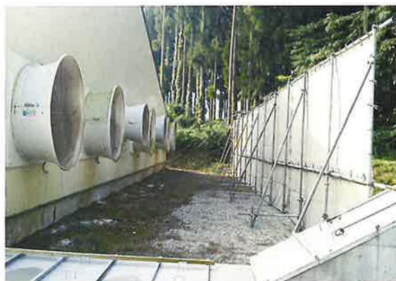
除塵布の設置
