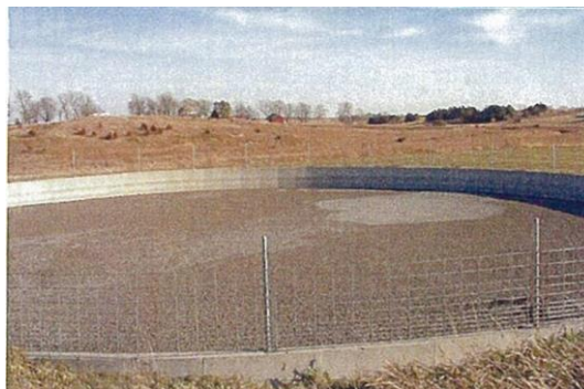
人工熔融岩石でカバーしたコンクリートピット内の液状豚ふん尿
