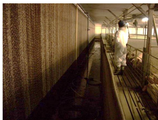
写真2 密閉型豚舎のバイオフィルター設置例
