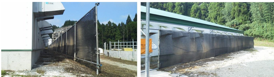
写真3 排気口への遮蔽壁の設置
