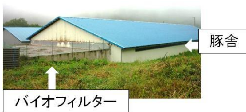
写真 10 豚舎の排気口のバイオフィルター設置例
