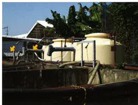
写真 2 臭気捕集タンクの排気側
