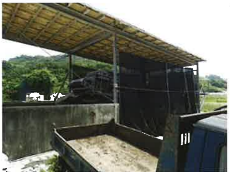
写真 9 コの字型に防風ネットを設置 (固液分離機周辺)
