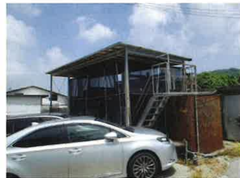
写真 9 コの字型に防風ネットを設置 (固液分離機周辺)
