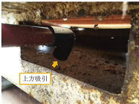
写真 5 吸気口 (南側) の向き
