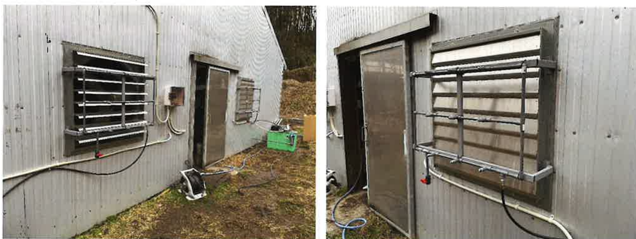
写真2 設置した強制換気システムと噴霧装置 噴霧ノズル（9個設置、空円錐ノズル 微霧発生極小噴量形 KB シリーズ （1/4MKB80125N）噴霧量 4.1L/h（0.7MPa）、粒子径 45~60 \mu m
