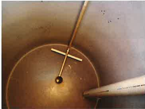
写真 3 散気管
