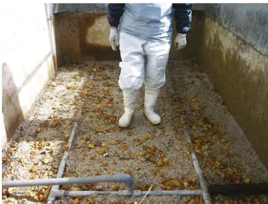
写真3 ファイバーボール脱臭装置（8 m 2 、表面に散水装置を設置）
