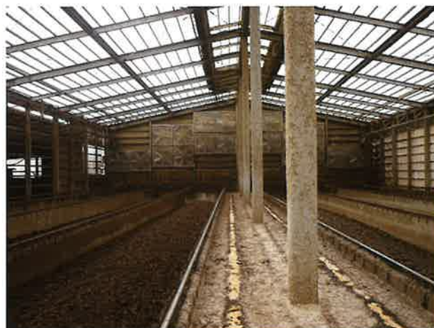
写真2 妻側に設置された換気扇群
