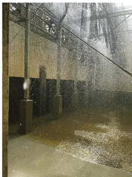
写真4 水洗脱臭装置の内部
