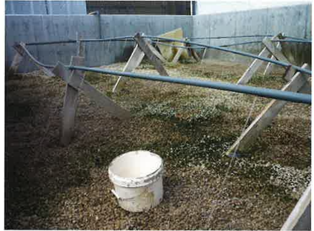
写真4 軽石脱臭装置の表面
