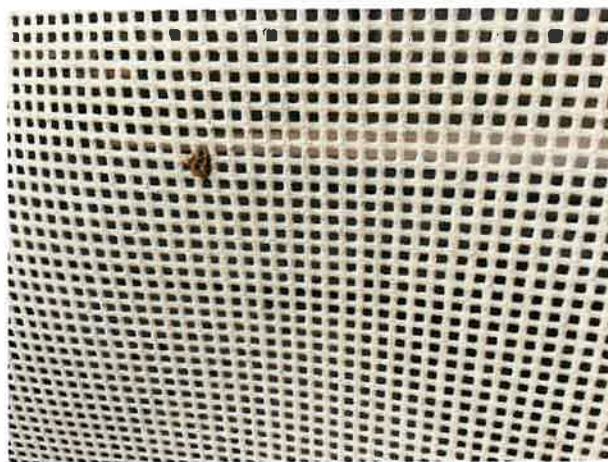
写真2 遮へい壁と使用ネット（目合い2mm）
