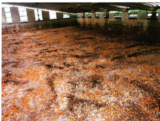
写真3 ロック脱臭槽上部（散水装置あり）
