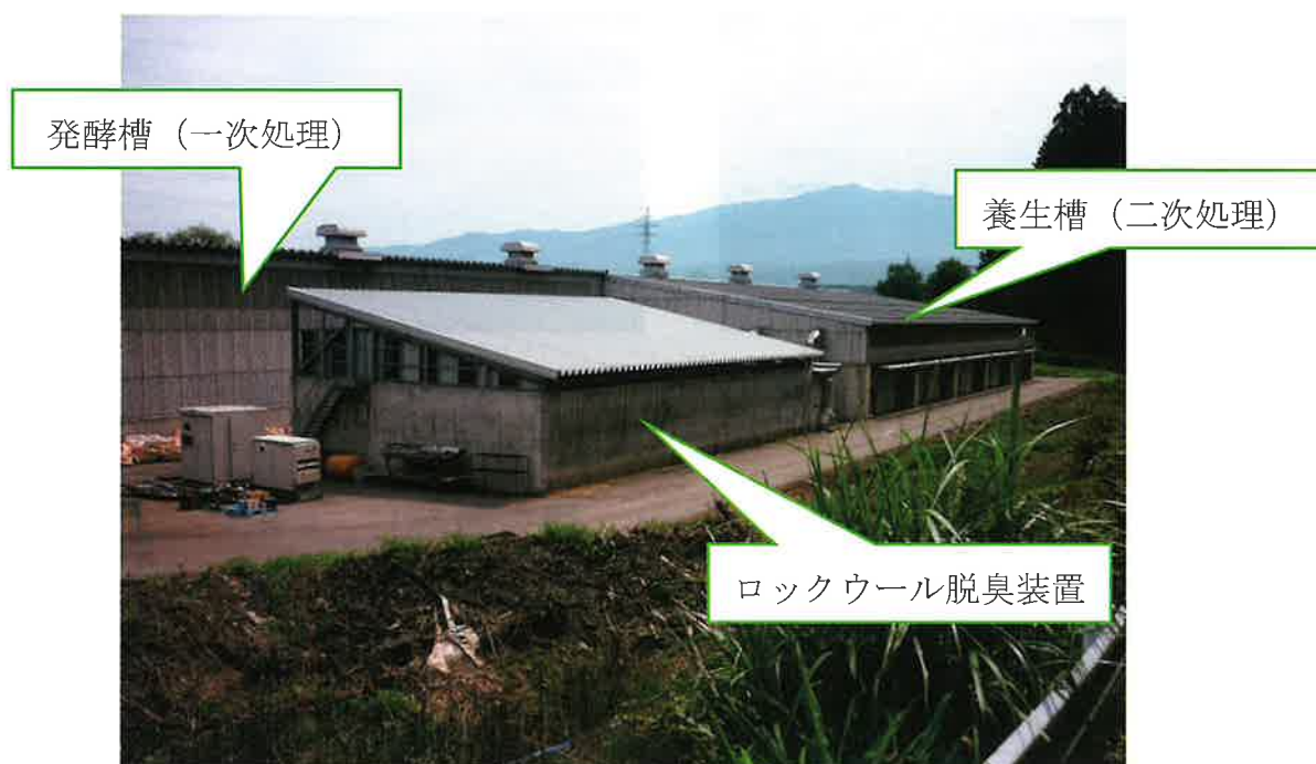
写真1 共同利用型堆肥センターのロックウール脱臭装置
