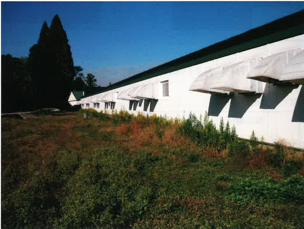
写真 1 分娩豚舎の換気口(フードの部分、換気口から敷地境界まで 10m 程度離れている)
