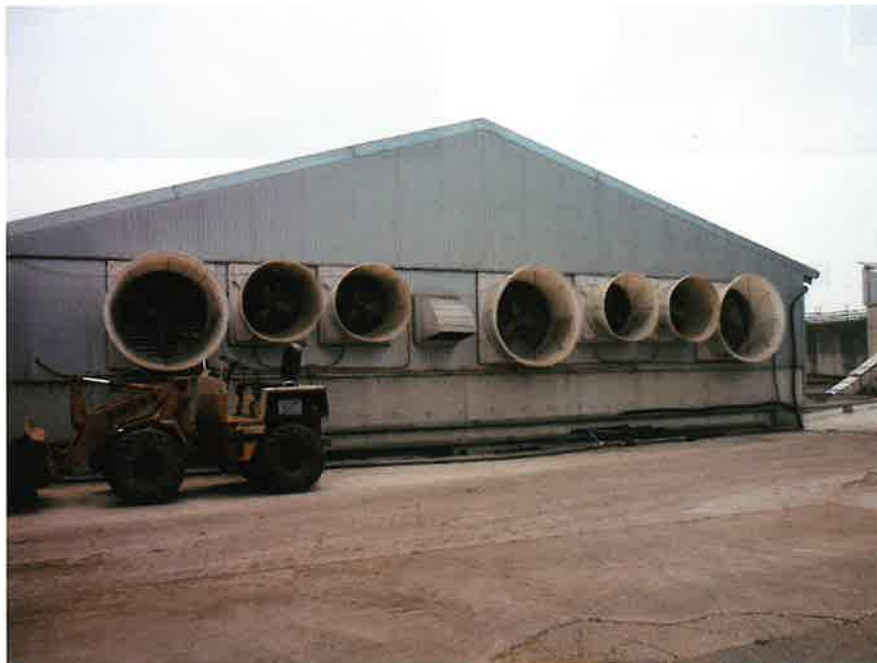
写真 1 繁殖豚舎の妻側に大型の換気扇が配置されている
