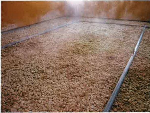
写真2 脱臭層上部表面（散水装置付き） 写真3 ガラス発泡材
