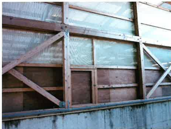
写真4 脱臭装置周囲はネットで囲われている
