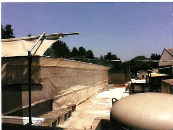
写真2 遮へい壁と使用ネット（目合い2mm）
