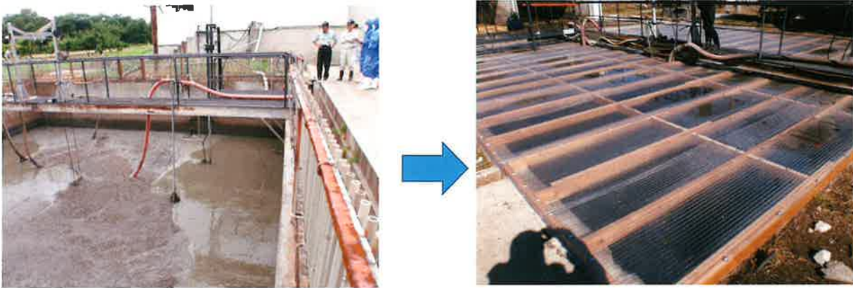
写真1 左：原尿槽に蓋がないときは強烈な臭気が拡散 右：原尿槽に蓋をして覆ったとき臭気の発生が大幅に抑制
