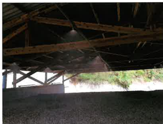
写真 2 軽石脱臭装置（軽石堆積高さ 4m）
