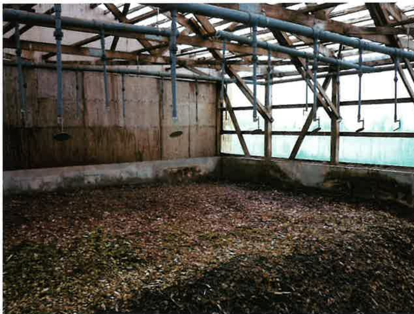
写真2 ウッドチップ脱臭槽(上部から間欠散水)
