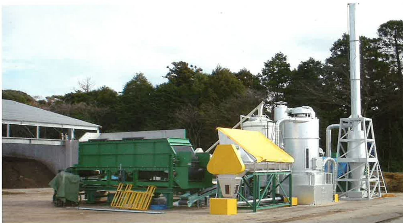
写真9 堆肥燃焼実証プラント
