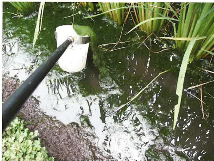
写真4 繁茂した藻が排水時にダムになっている例
