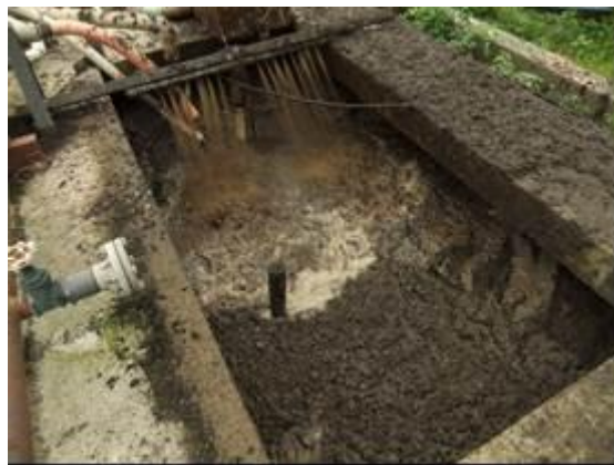
図 41 スカム破碎装置の事例
