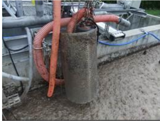
図 109 異物混入防止用に取り付けたパンチングメタルカゴ
