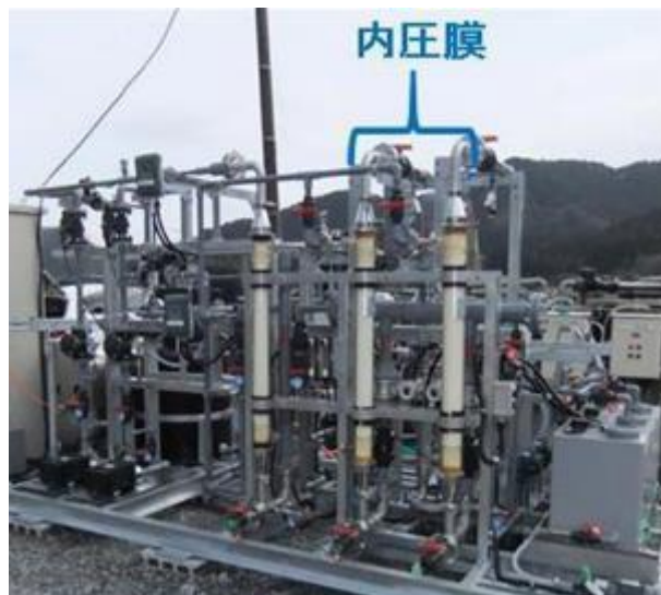
図 168 内圧中空糸膜の試験状況
