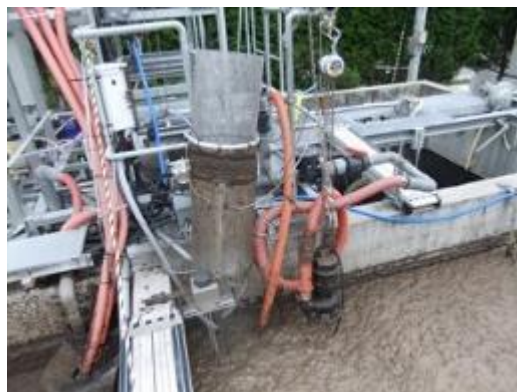
図 111 長さを延長したパンチングメタルカゴ
