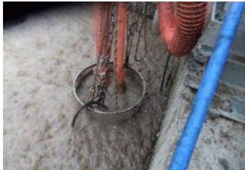
図 110 水中ポンプ稼働時の吊下げ状況
