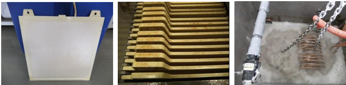
図 26 平膜の事例（左：単位膜、中央：膜モジュール、右：曝気槽に浸漬されたモジュール）
