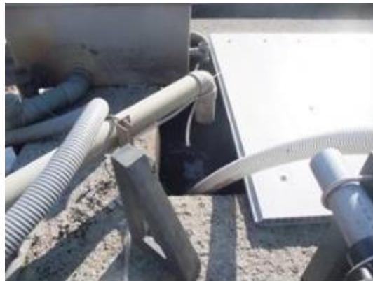
図 46 メタノール添加用チューブ (塩ビ管の下部の直径約 1cm のチューブ)
