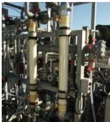
図 83. 外圧中空糸膜（吸引ろ過）モジュールの試験状況
