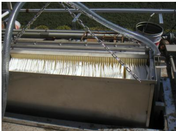
図 27 中空糸膜の事例 (曝気槽に浸漬する前のモジュールの状況)
