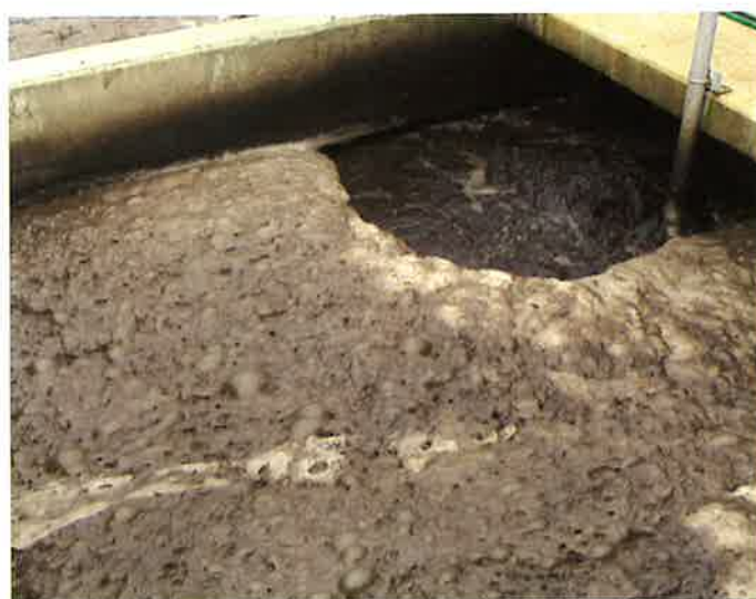
活性汚泥が多すぎることによるばっ気槽の発泡
