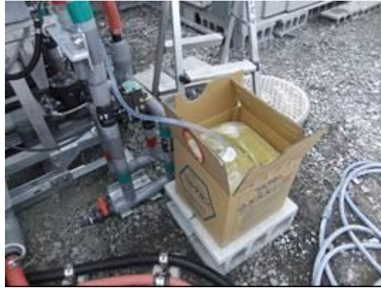
図 7. 自動洗浄に使用する市販 12%次亜塩素酸ソーダ
