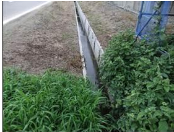
図6. 放流先の道路側溝
