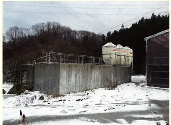
実証試験を行った污水浄化処理施設 (冬期で積雪している)
