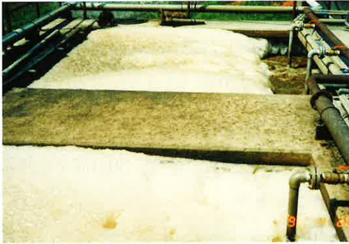
泡が溢れている曝気槽
