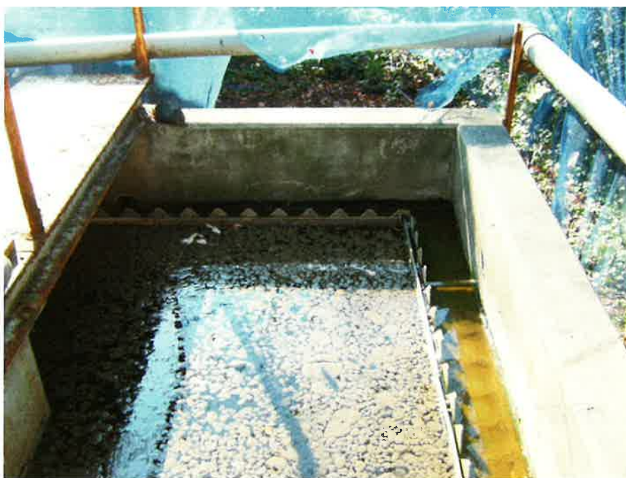
汚泥の浮いた沈殿槽
