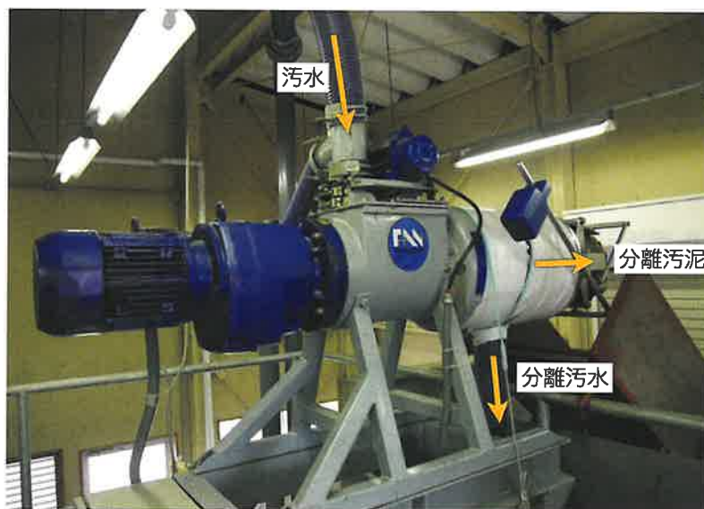
図6-21 スクリュープレス型固液分離機
