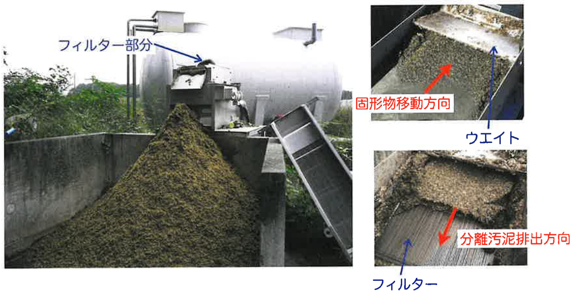
図6-23 多板波動型スクリーンの全景（左）およびフィルターの水導入部（右上）と分離汚泥排出部（右下）
