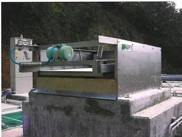
図6-17 振動篩型固液分離機の外観（左）と構造（右）
