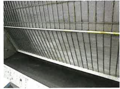
裏面高圧洗浄機清掃後の状態
