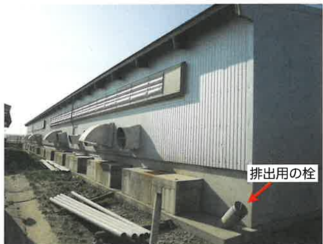
図6-4 排出用の栓が舎外にあるタイプのふん尿混合豚舎
