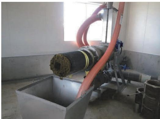
図4. 固液分離機 (消化液対象)
