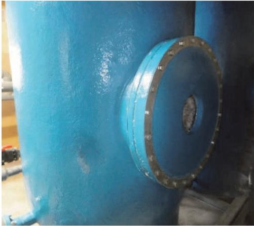
図 6. 生物脱硫槽
