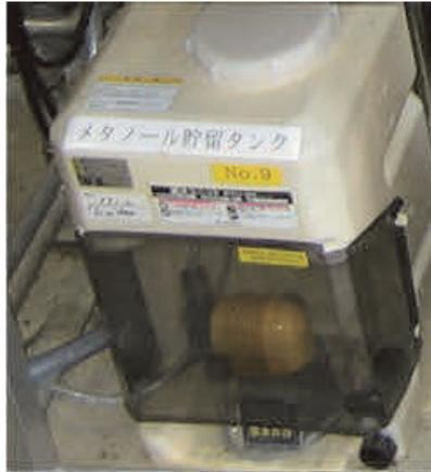
図 5. メタノール貯留タンクと定量ポンプの一体型機器事例
