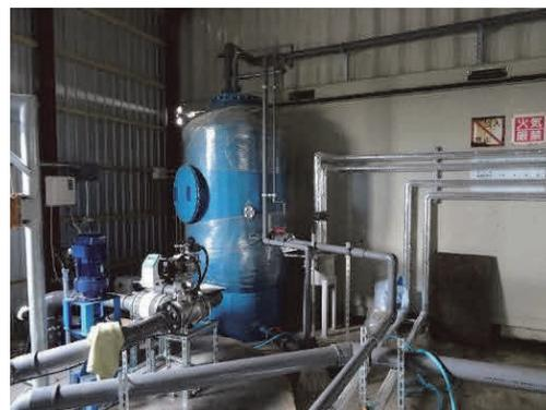
図3. 生物脱硫槽
