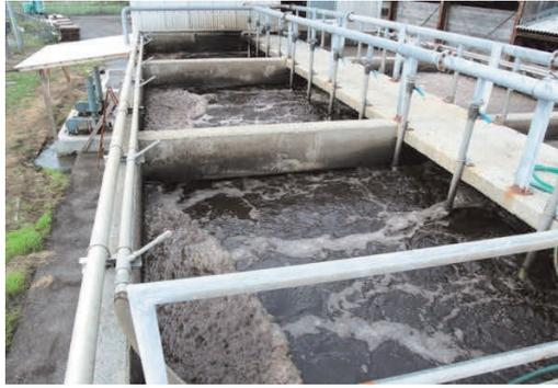
図1. 標準タイプ曝気槽の事例
