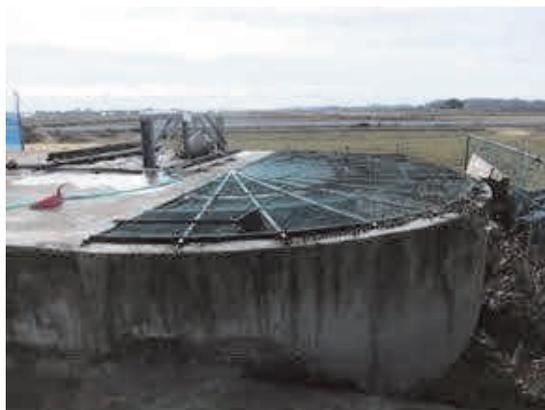
図4. オキシデーションディッチタイプ曝気槽の事例
