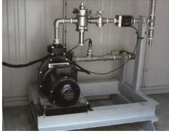
図 4. 膜分離用吸引ポンプの事例
