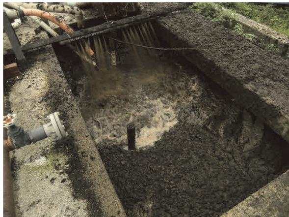
図 1. 脱窒槽のスカム破碎装置事例
