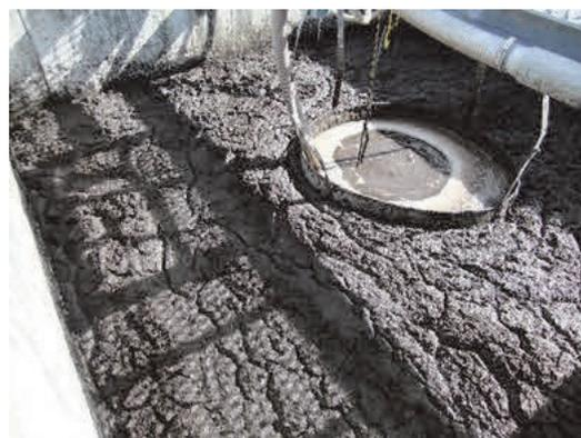
図2. 沈殿槽のスカム発生トラブル事例
