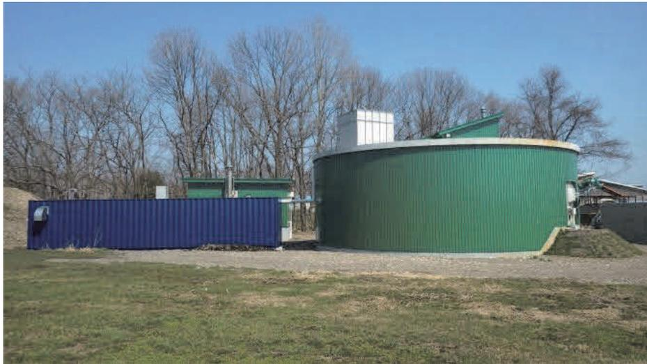
図 2. ガス貯留施設（左）および発酵槽（右）
