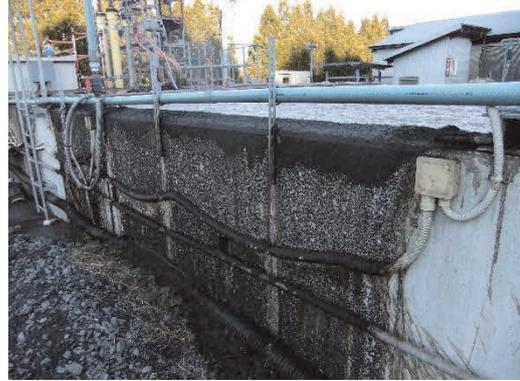
図1. 異常発泡による曝気液の流出事例
