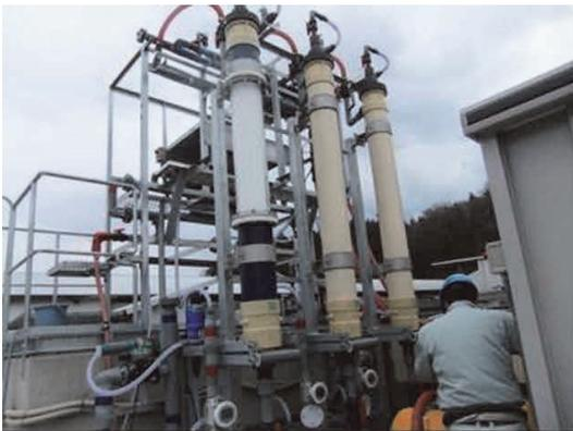
図2. ケーシング膜の取付け状況
